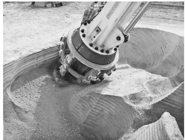
写真一 3 模擬地盤 (qu=5.0 N/mm 2 程度) 掘削状況
