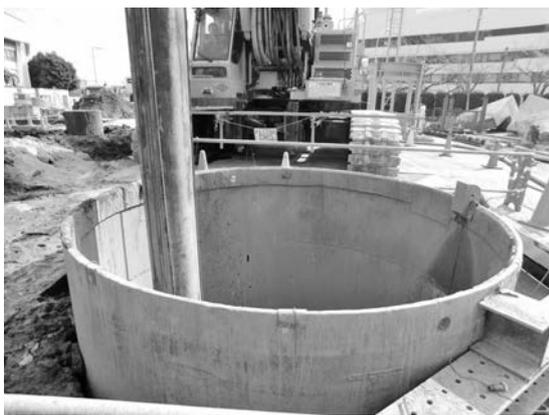
写真-6 偏心拡底掘削時の状況
