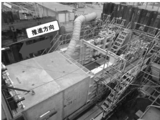
写真一2 函体掘進状況
