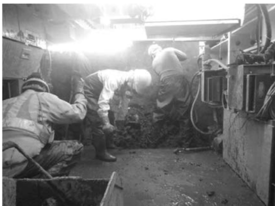
写真一3 内部掘削状況
