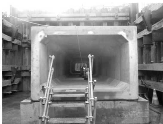
写真一 5 施工完了
