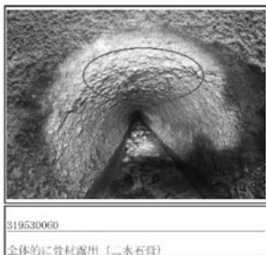
写真一2 項目：腐食 ランクB 骨材露出(全体)
