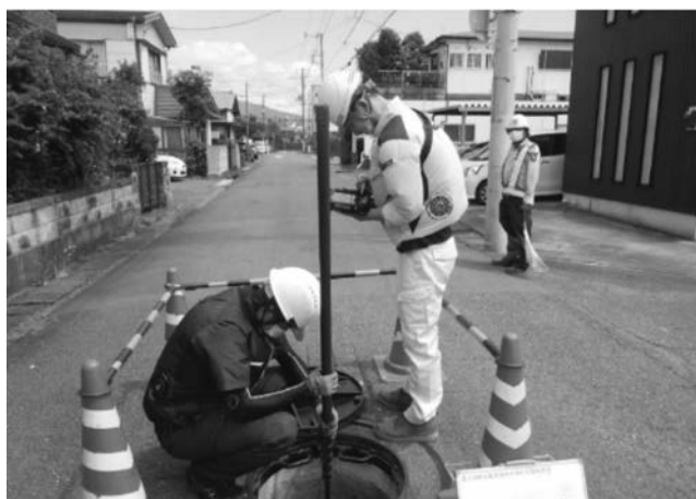
写真一5 現地作業状況
