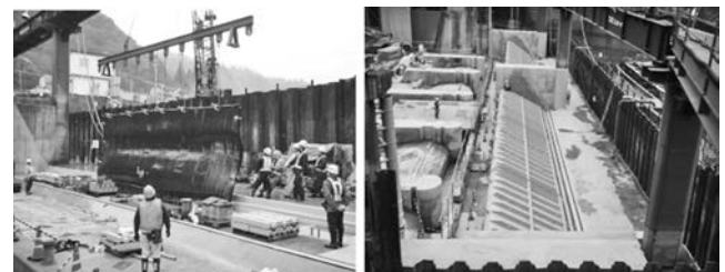
写真一 9 ゴム袋体と壁体設置状況
