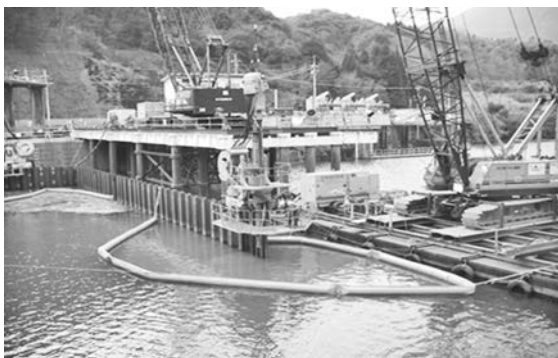
写真—4 仮締切鋼矢板打設状況 (1期)
