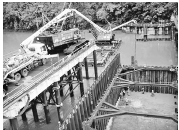
写真—6 右岸側均しコンクリート打設
