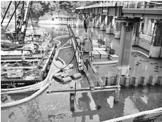
写真一 7 止水矢板打設状況 (2期)
