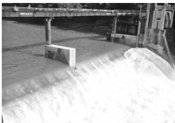
写真-12 SR堰倒伏状況
