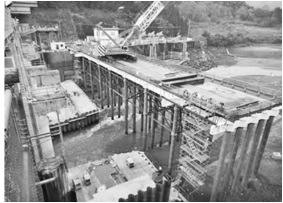
写真一 2 上流作業構台設置状況
