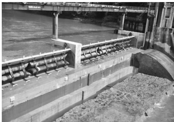
写真-11 SR堰起立状況
