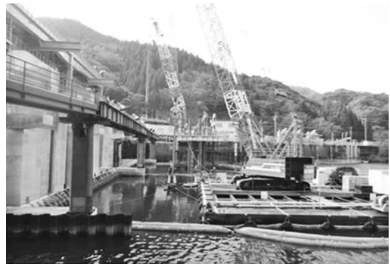
写真一 3 80 t クレーン台船作業状況 (5 期)
