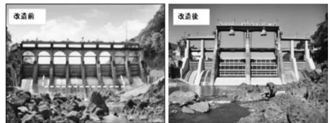
写真-1 改造前後の西郷ダムの全景
