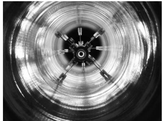
写真-1 人孔内光射装置
