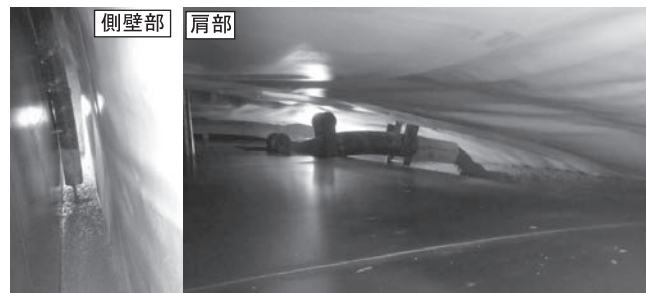
写真一七 本システムによる打設状況
