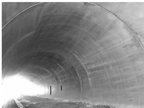
写真—8 仕上り状況
