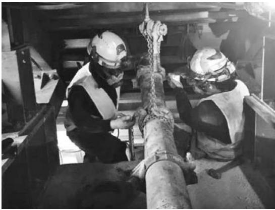
写真一 配管切替作業
