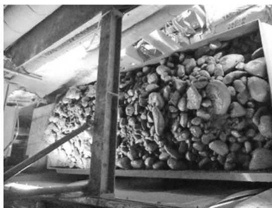
写真一5 礫排出状況
