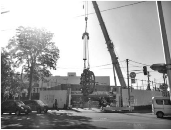
写真一七 新規カッターヘッド投入状況
