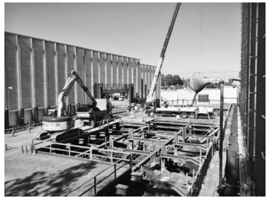
写真-1 呑口部掘削・山留施工状況
