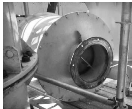
写真—9 消音マフラーのみ
