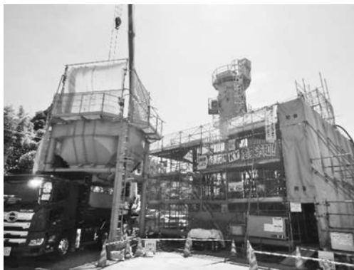
写真—7 ニューマチックケーソン施工状況
