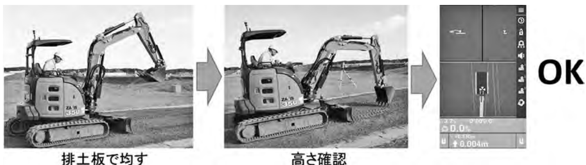
図一17 小規模敷き均し作業方法
