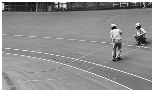
写真-1 目視によるひび割れ調査状況
