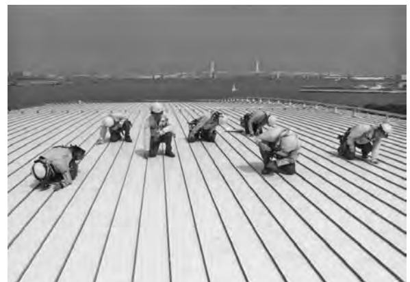
写真一10 屋根ステンレスシーム溶接の自主検査 (従来)
