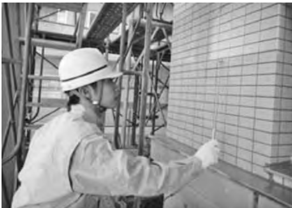
写真—1 全面打診による従来の外壁タイル調査例
