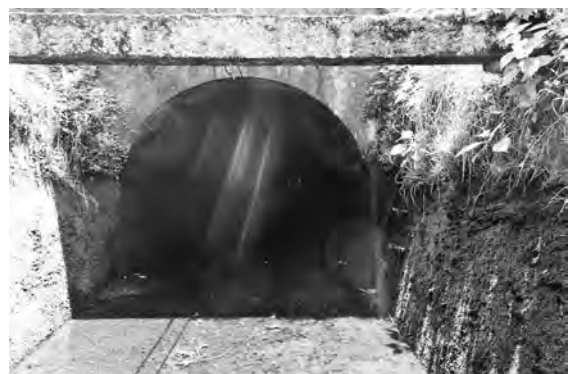
写真—2 水路壁面の状況
