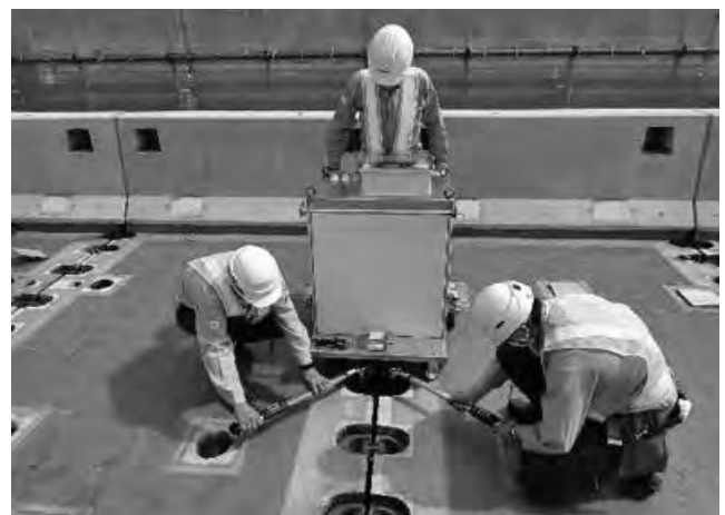
写真—15 検査状況(出来形検査システム)
