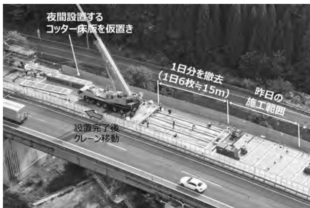
写真一11 床版撤去・設置を1日サイクルで施工する場合
