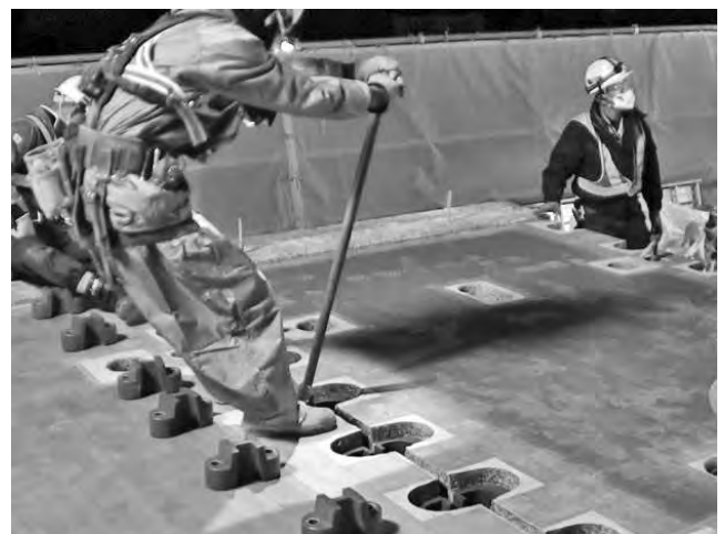
写真一 4 専用治具による引寄せ状況
