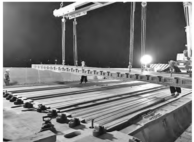
写真一 3 コッター床版の架設状況
