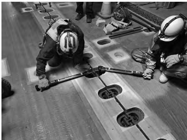
写真一六 固定用ボルト締付け状況
