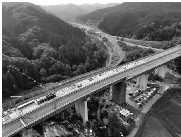
写真一九 工事全景写真
