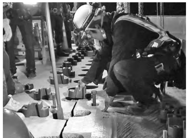
写真一 5 H 型金物の挿入状況
