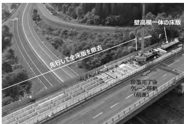
写真一12 床版撤去を先行する場合
