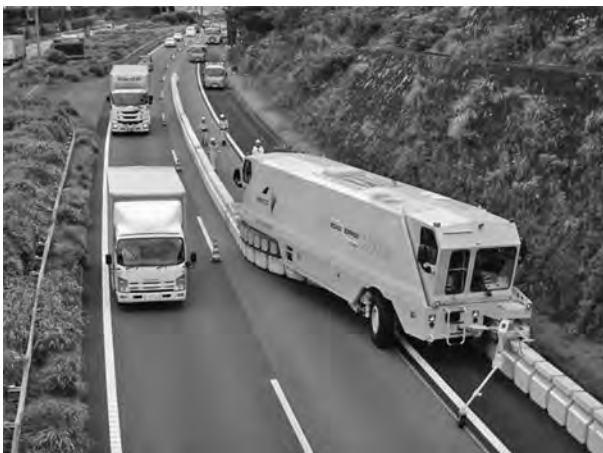
写真一四 RZS (専用車両によるコンクリート防護柵の移動)
