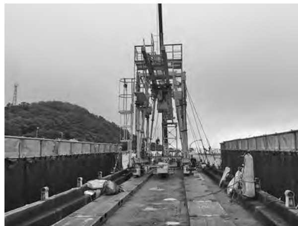
写真一3 床版取替機によるプレキャスト床版の架設
