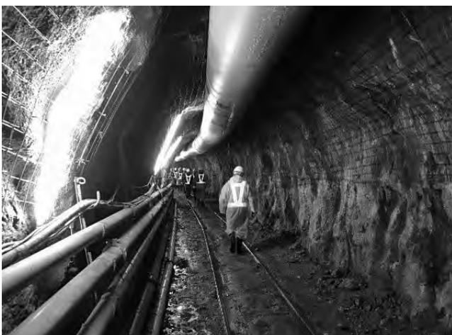
写真一八 坑内標準断面
