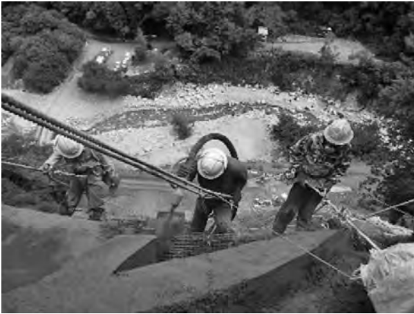
写真一七 墜落制止用具（安全帯）の使用事例
