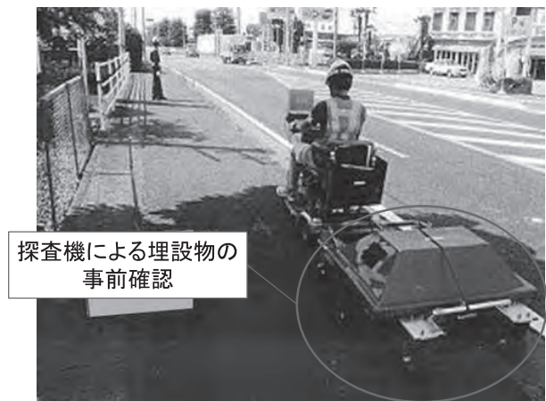
写真一一 探査機により埋設物の事前調査を行った事例
