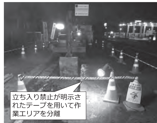
写真四 立ち入り禁止区域の明示を行った事例
