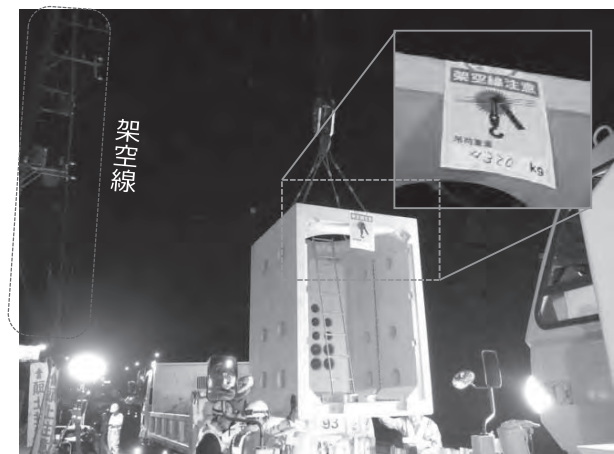
写真三 吊り上げ資材に架空線注意の表示を設置した事例
