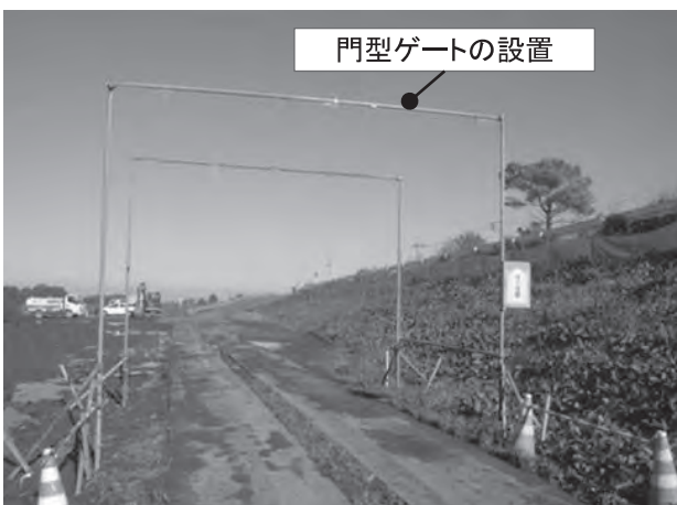
写真二 門型ゲート設置の事例
