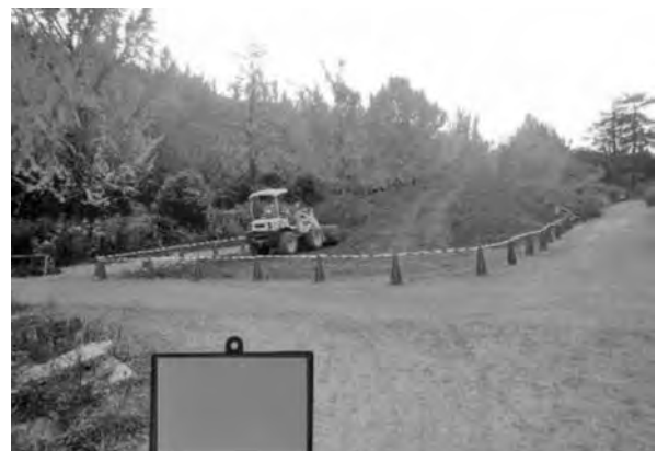
写真五 重機稼働範囲と運搬路の分離を明示した事例
