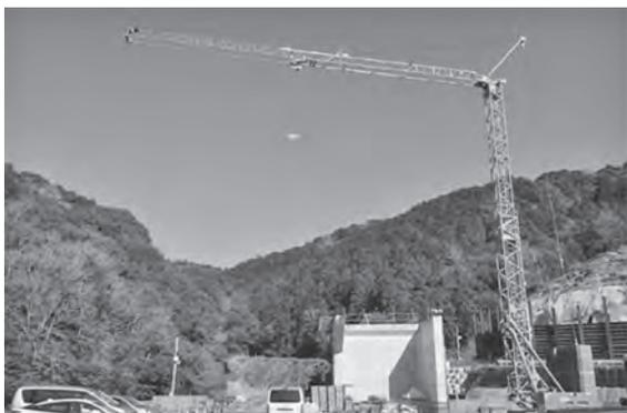
写真一 定置式水平ジブクレーン
