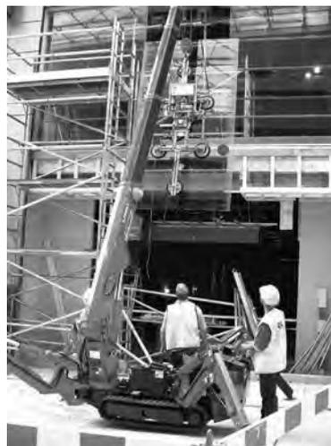
写真—2 ガラスパネルのつり上げ作業
