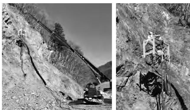
写真一 4 クレーン吊り下げ式吹付ロボット施工状況
