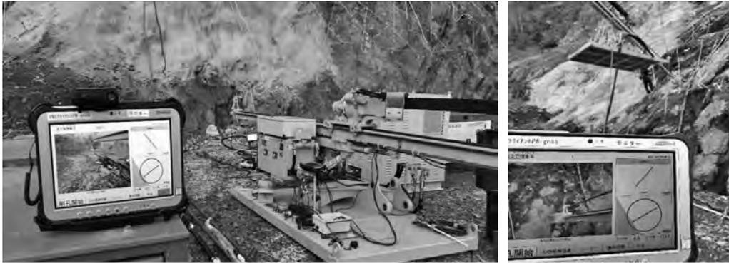
写真一 5 遠隔削孔システム施工状況
