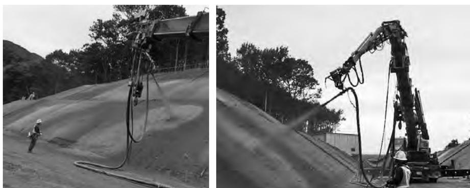
写真一3 アタッチメント式吹付ロボット施工状況
