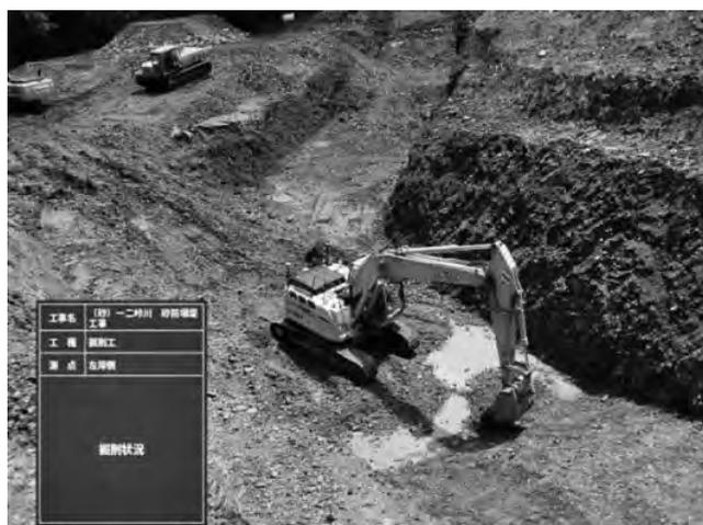
写真—3 ICT 建機による掘削
