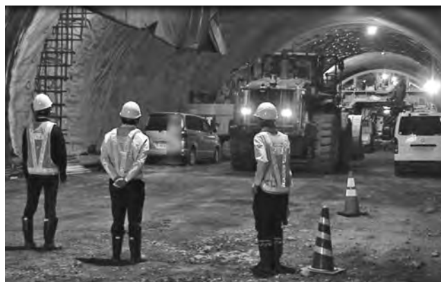
写真一 7 トンネル内での実機検証状況
