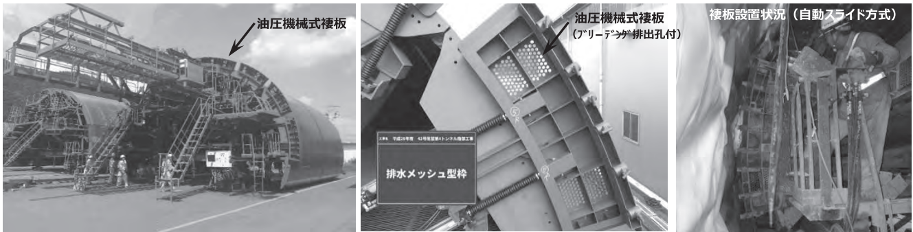
図一 3 油圧機械式鋼製襖板の概要
