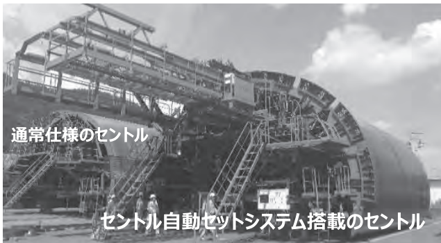
写真—1 使用したセントルの全景
