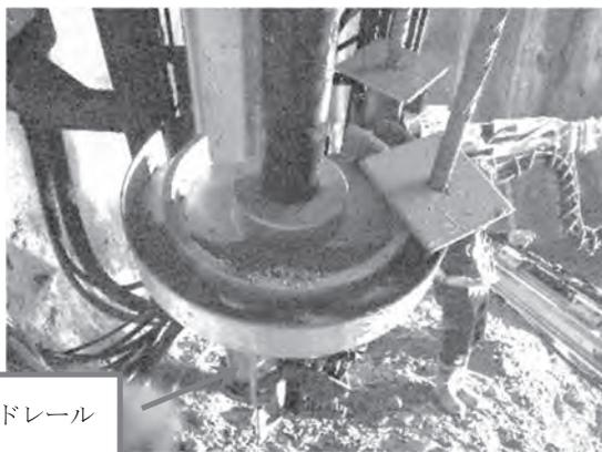
写真-11 ターレット下板ズリ堆積状況
