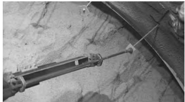
写真一2 ロックボルト挿入状況
