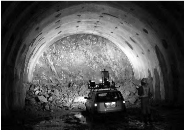
写真—3 掘削出来形・地質データの取得状況
