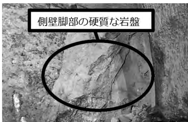
写真—8 側壁脚部の硬質な岩盤
