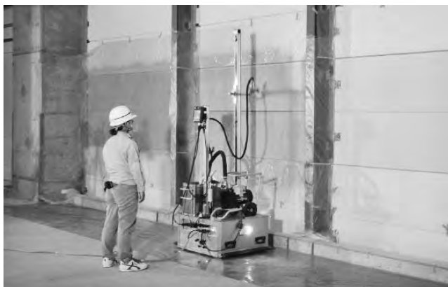
写真1 塗装ロボットの施工状況
