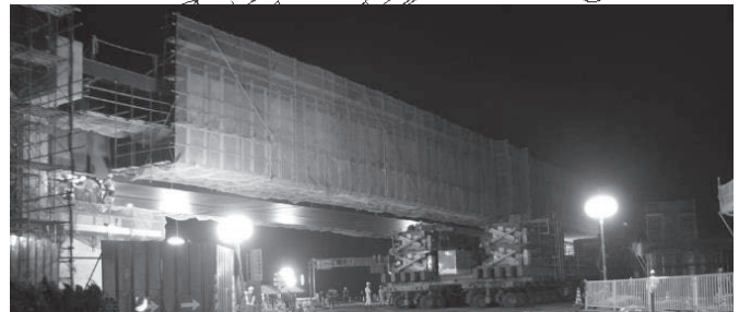
b) 多軸式移動台車による桁架設
