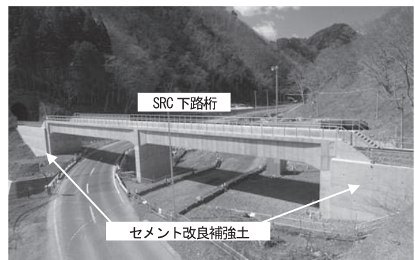
図一五 補強盛土一体橋りょう (GRS 一体橋りょう) 7)
