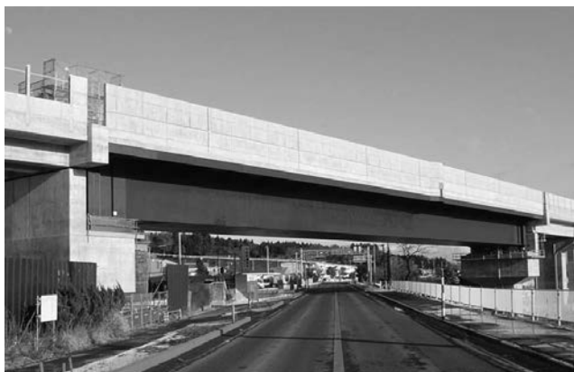
a) 完成した単純合成桁
