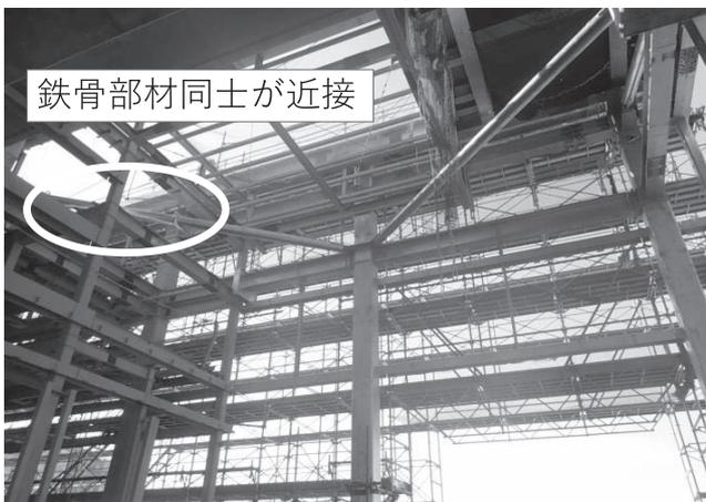
写真一3 鉄骨部材の近接
