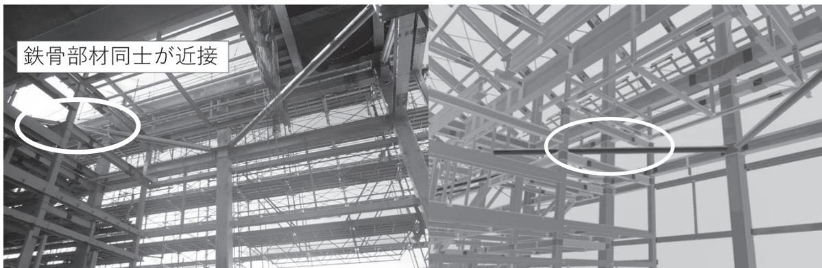
図一12 鉄骨部材(ハイブリッド構造材と耐風梁)の干渉の確認
