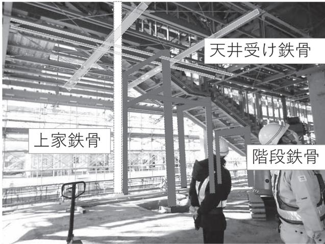
写真一2 異なる用途の鉄骨の転換
