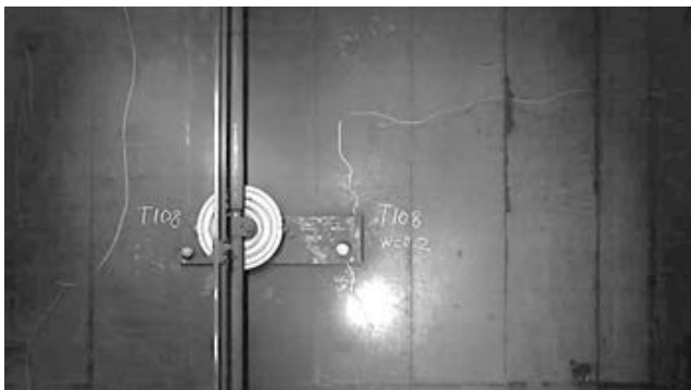
写真-3 実証実験で取得した高解像度カメラ画像（東急田園都市線トンネル内）
