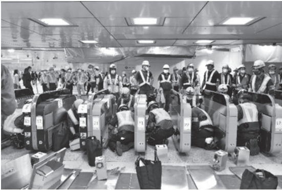
写真一 3 改札切替作業の様子
