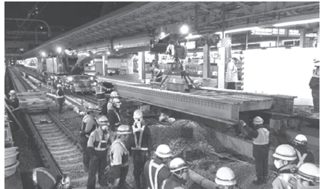
写真一1 鉄道クレーンによる工事桁架設・撤去 (写真は撤去時の様子)
