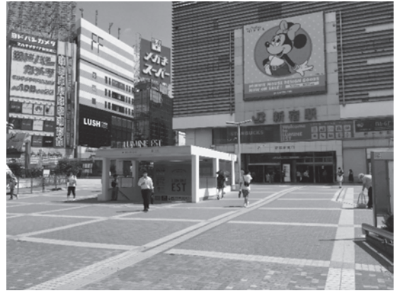
写真一 5 使用開始した東口駅前広場北側広場
