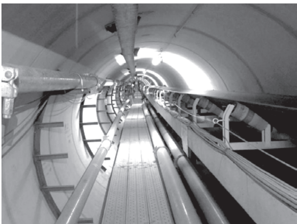
写真一 搬出入用工事用トンネル
