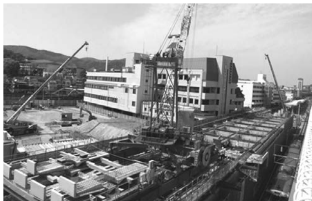
写真—3 HPca 架設状況
