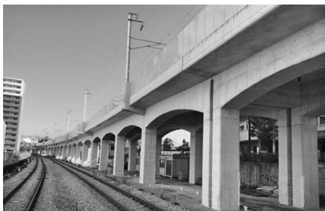
写真—1 背割式ラーメン高架橋
