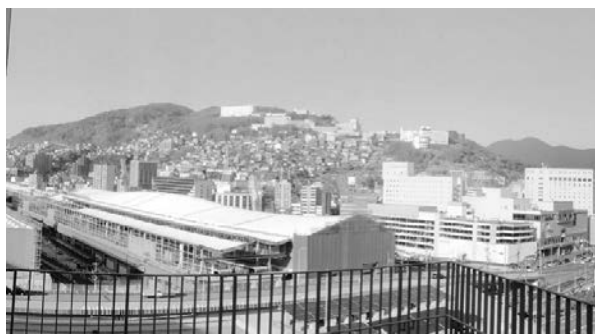
写真一九 長崎駅付近状況
