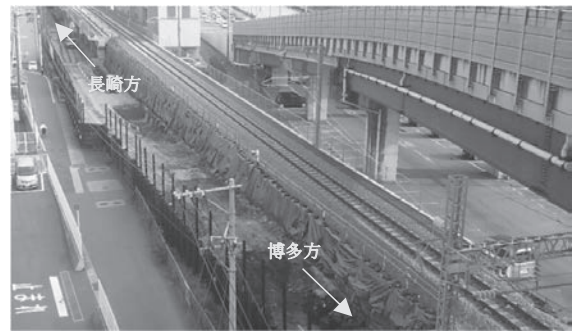
写真—4 高架切替点(開業時)
