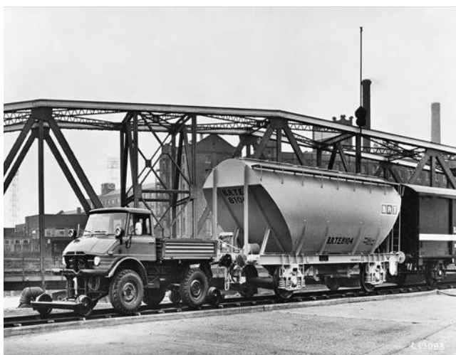
写真一 3 牽引作業用大径ガイドレール付
