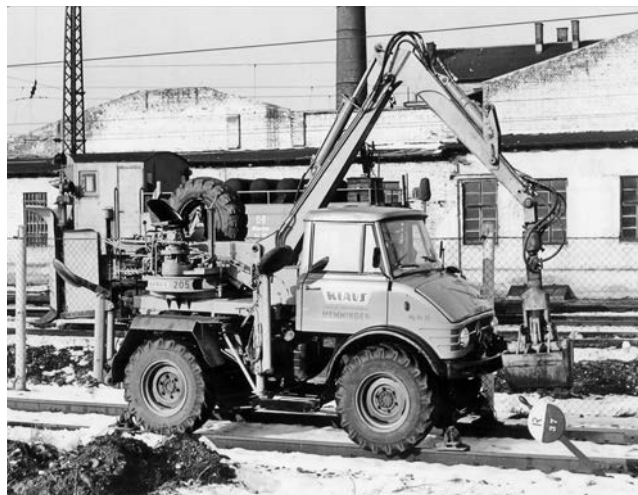
写真—1 ガイドスキッド・掘削機付
