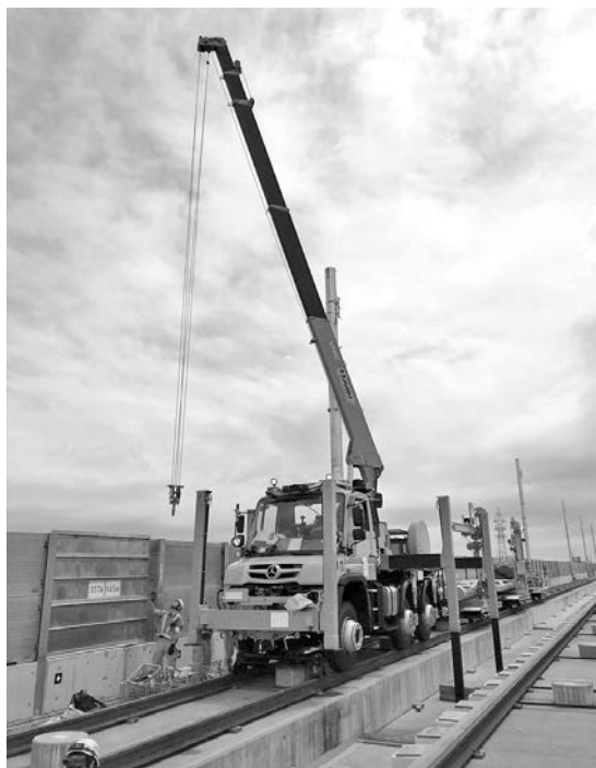
写真一8 電化柱建植作業
