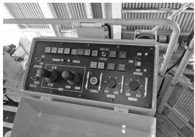
写真—6 作業台上, 簡易操作盤
