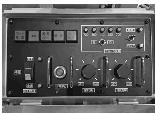
写真—11 簡易走行操作盤
