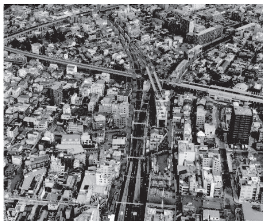
写真-1 現場全景写真
