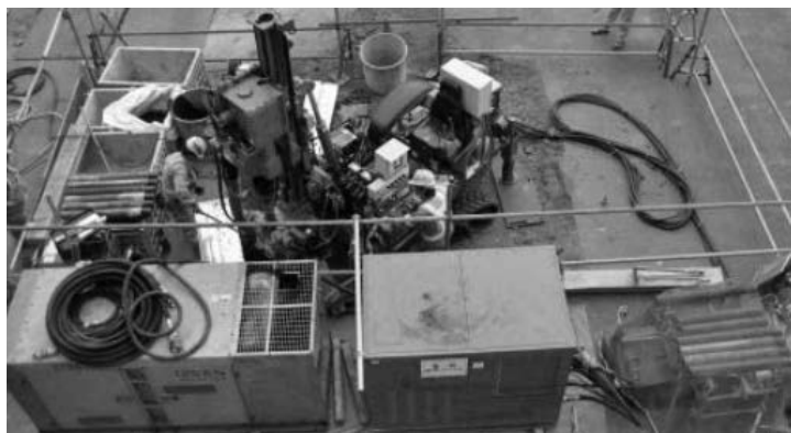
写真二-2 狭隘環境下での施工状況
