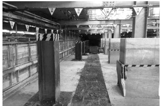
撮影協力・画像提供：JR 東日本 写真—5 施工完了状況
