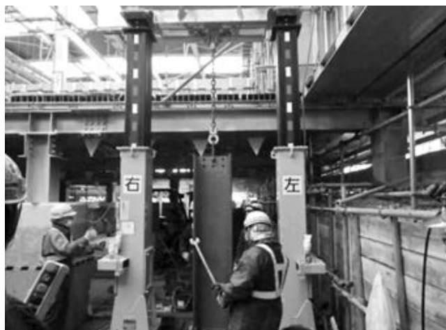
撮影協力・画像提供：JR 東日本 写真—4 ソイルセメントH形鋼杭 芯材建込機
