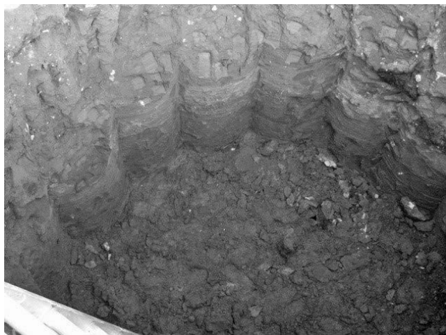
写真一-1 ソイルセメント防護壁掘り出し状況
