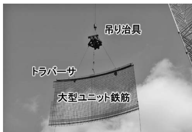
写真一3 大型ユニット鉄筋揚重状況
