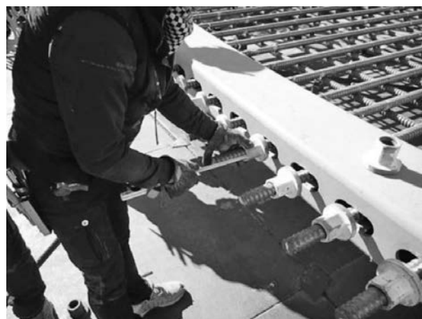
写真一2 トラバーサと鉄筋との固定方法
