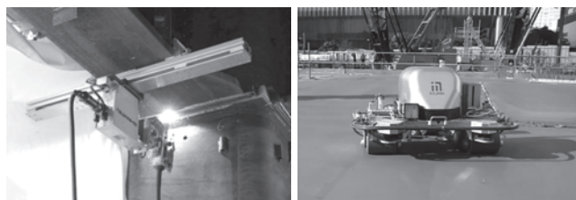
写真一六 (左) 溶接ロボット作業状況 (右) コンクリート床仕上げロボット
