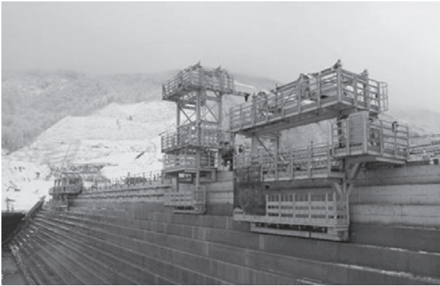
写真一3 置き型枠自動スライドシステム
