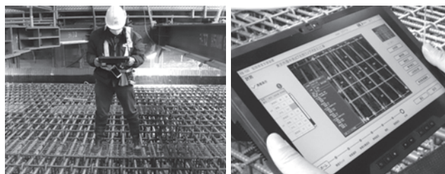
写真一5 配筋検査システム
