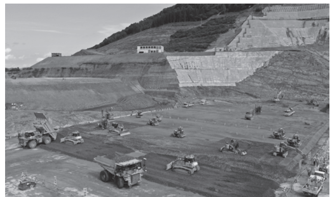
写真一 1 A 4 CSELによる堤体自動打設 (成瀬ダム工事/東北地方整備局)
