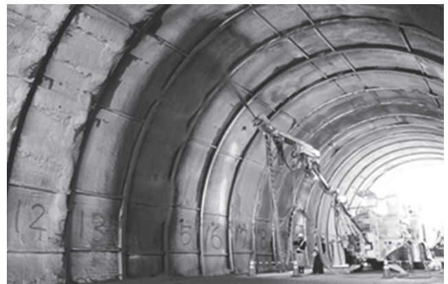
写真一4 模擬トンネルでの自動吹付け実験
