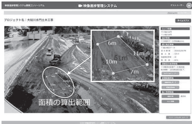
図-6 資材ヤードの面積計測
