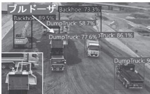
図-11 ダンプと重なった状態のブルドーザ
