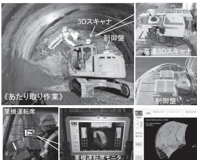
図一3 掘削形状モニタリングシステム
