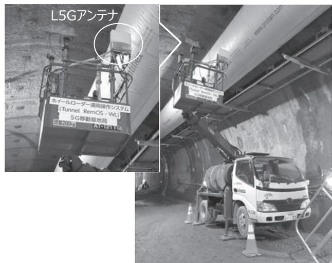
写真一4 映像・制御信号通信システム（坑内固定ユニット【L5G仕様】）
