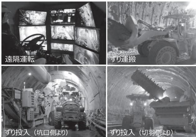
写真一5 トンネル坑内における遠隔操作実験状況
