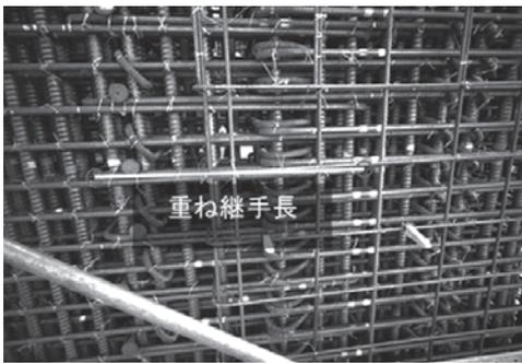
写真一6 重ね継手長さ計測状況
