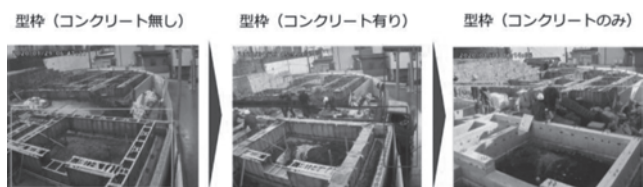
写真—3 型枠施工～脱枠期間での施工部材認識結果
