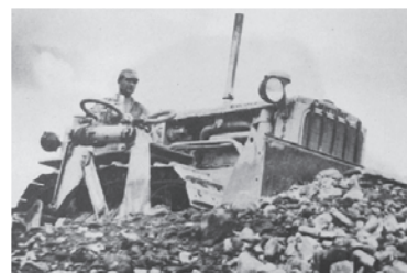
豊満ダムのブルドーザ
