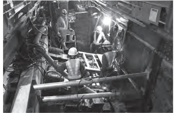
写真一6 推进機引き抜き状況
