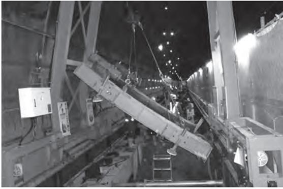
写真一2 推进架台設置状況
