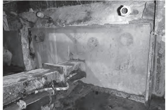
写真一7 コンクリート充填完了
