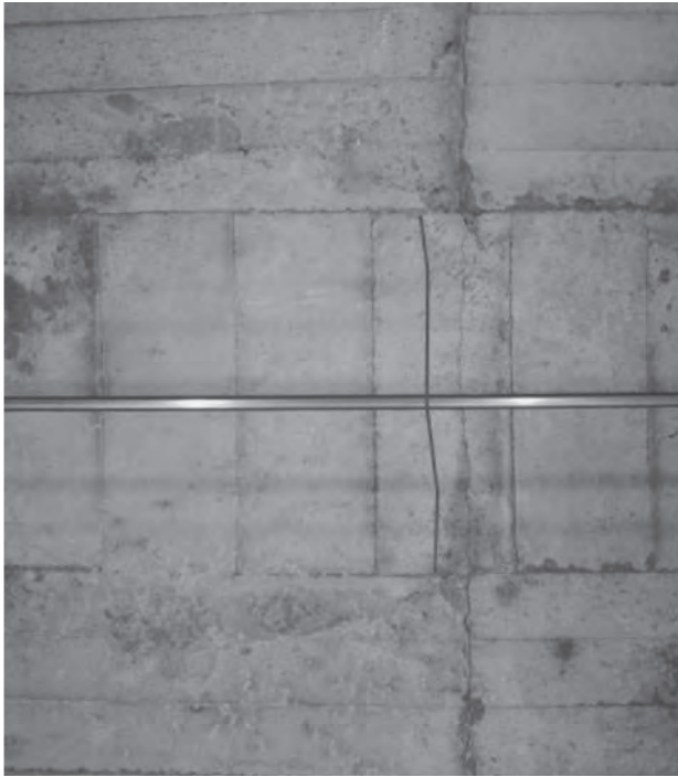
写真一 高精細デジタル画像によるひび割れ検出
