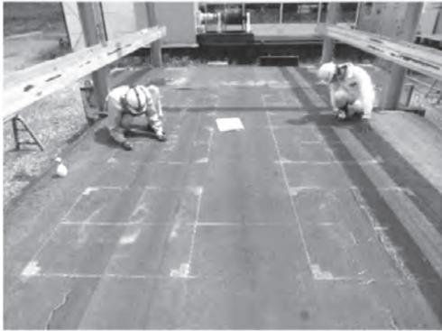
写真—11 ひび割れ調査状況
