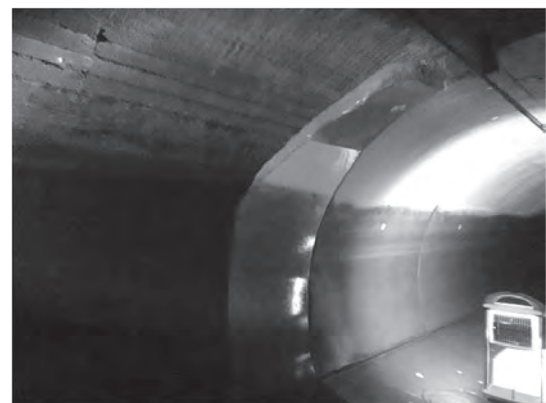
写真一七 内面補強区間での水位低下
