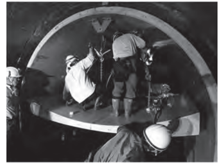
(c) レバーブロックによる底盤材の設置状況
