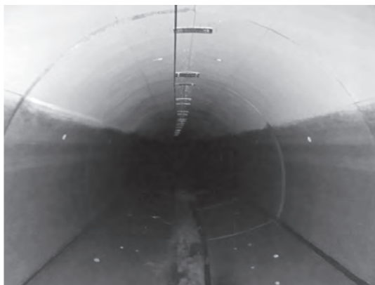
写真一６ １年経過後のプレキャスト内面補強工状況
