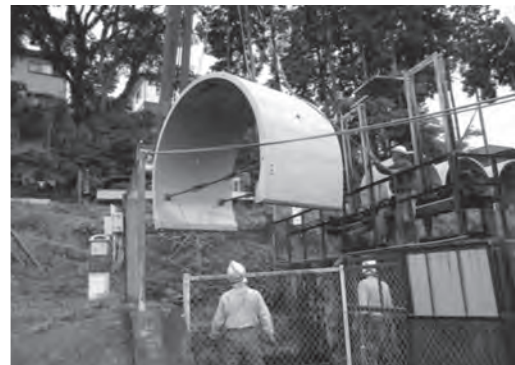
写真一 プレキャスト部材坑内搬入状況
