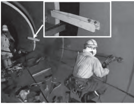
(a) レバーブロックによる後続部材の牽引
