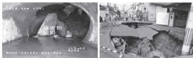
写真一 道路陥没状況
