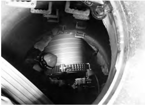
写真一五 マンホール内での製管機状況
