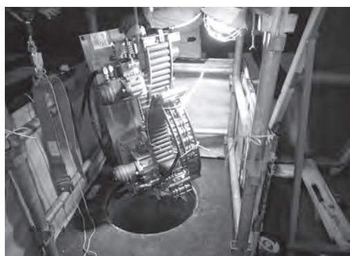
写真一 4 製管機の吊り下ろし状況
