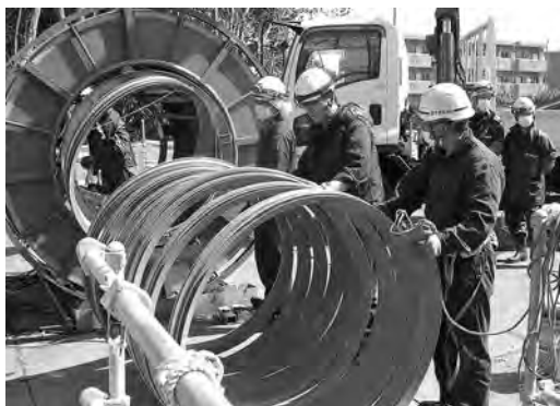
写真—11 プロファイルの巻き癖付与
