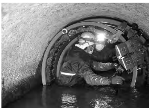
写真—12 製管状況
