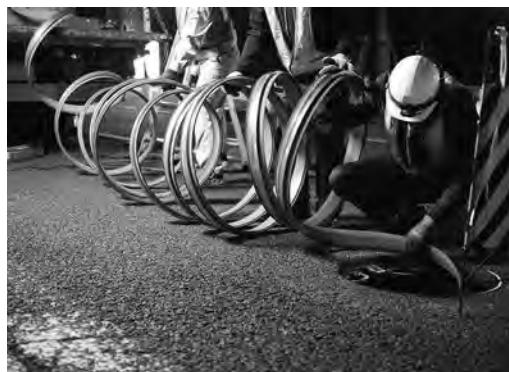
写真—13 プロファイルの送り込み状況
