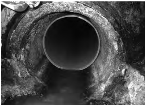
写真一六 製管状況
