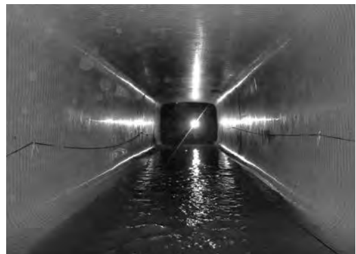
写真一〇 製管完了
