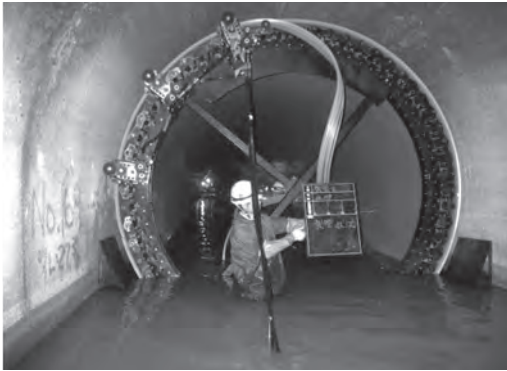
写真一 2 供用下で施工状況
