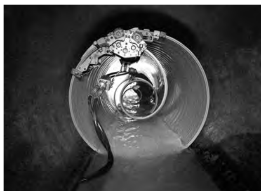
写真—14 製管状況
