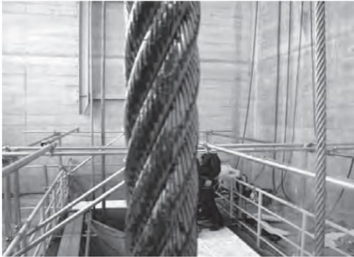
写真-13 めっき層の損失状況
