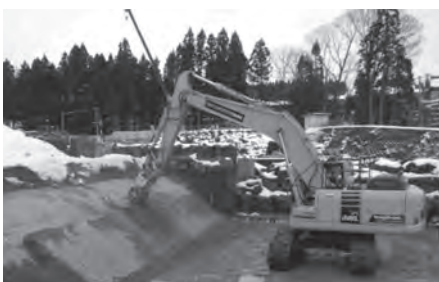
写真-3 ICT建機による固定堰はつり状況
