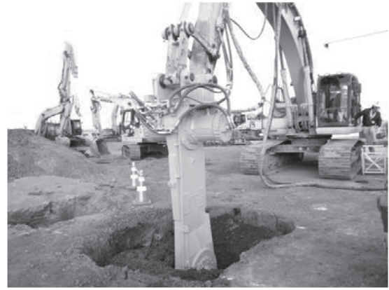
写真一3 透水性改良体造成状況
